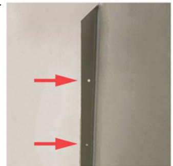
3) Žebra na bočním pláště vyplňte provlečením roxorových prutů síly min. 8mm do připravených otvorů.
